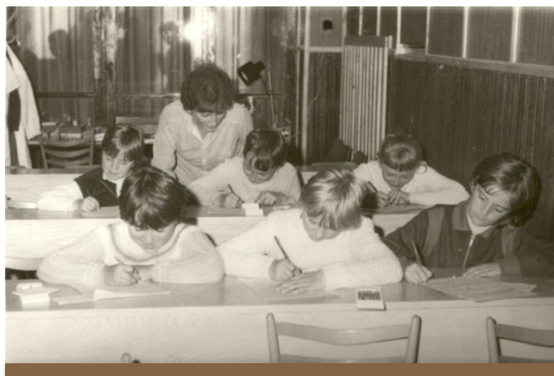
Obr. 2 Zrekonštruovaný priestor vo vestibule knižnice v roku 1984 (Podduklianska knižnica vo Svidníku)
