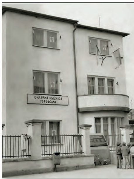
Budova Okresnej knižnice v Topolčanoch (foto autor neznámy – Archív Topolčany)
